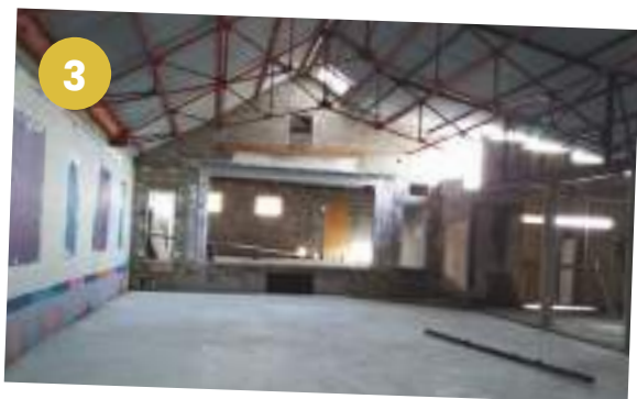
MAÇONNERIE INTÉRIEURE Déshabillage des murs et des plafonds Coulage de la dalle Retrait de la structure bois sous toiture
