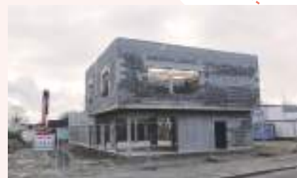
Construction du nouveau CMB
