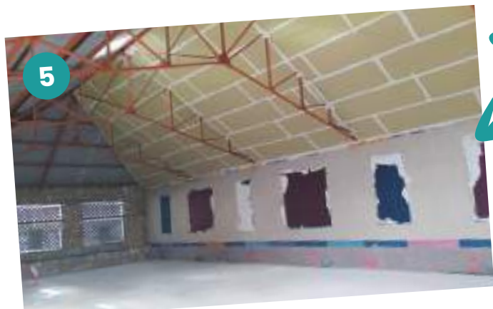
PLÂTRERIE Pose de l'isolation intérieure et des doublages Réalisation du cloisonnement
