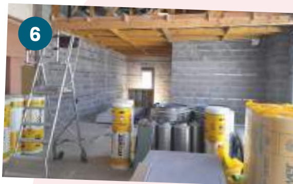
RÉALISATION DES ÉQUIPEMENTS TECHNIQUES Pose du réseau de gaines assurant la ventilation et le chauffage Isolation de l'extension
