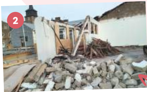
DÉSAMIANTAGE ET DÉCONSTRUCTION Déconstruction des anciennes salles de classe devenues bibliothèque
