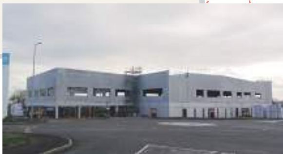
Construction du pôle santé
